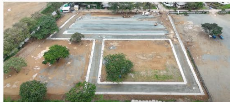
Ampliación zona sur; equipamiento tecnológico
